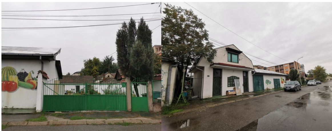
Slika br.4. Postojeće stanje na terenu
